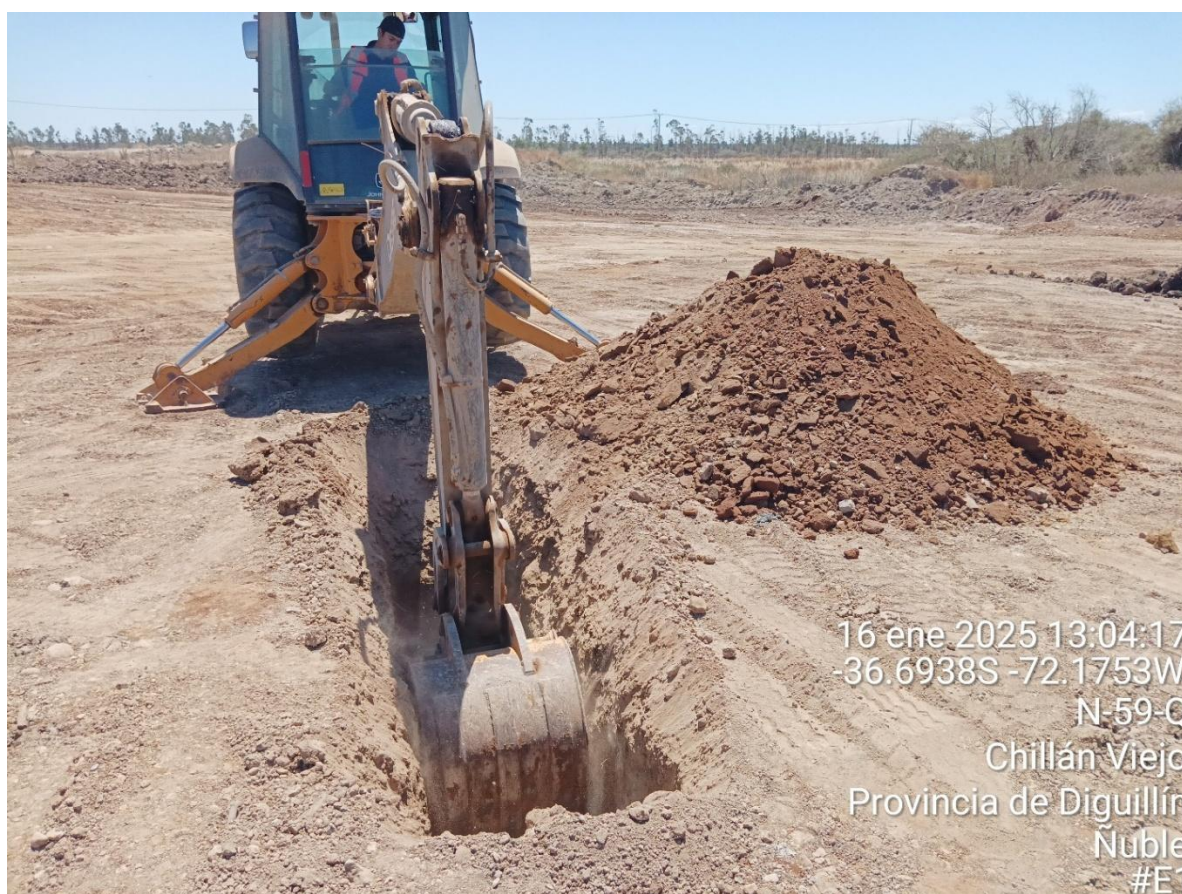
Figura 4 – Calicata tipo muestreo 2025
